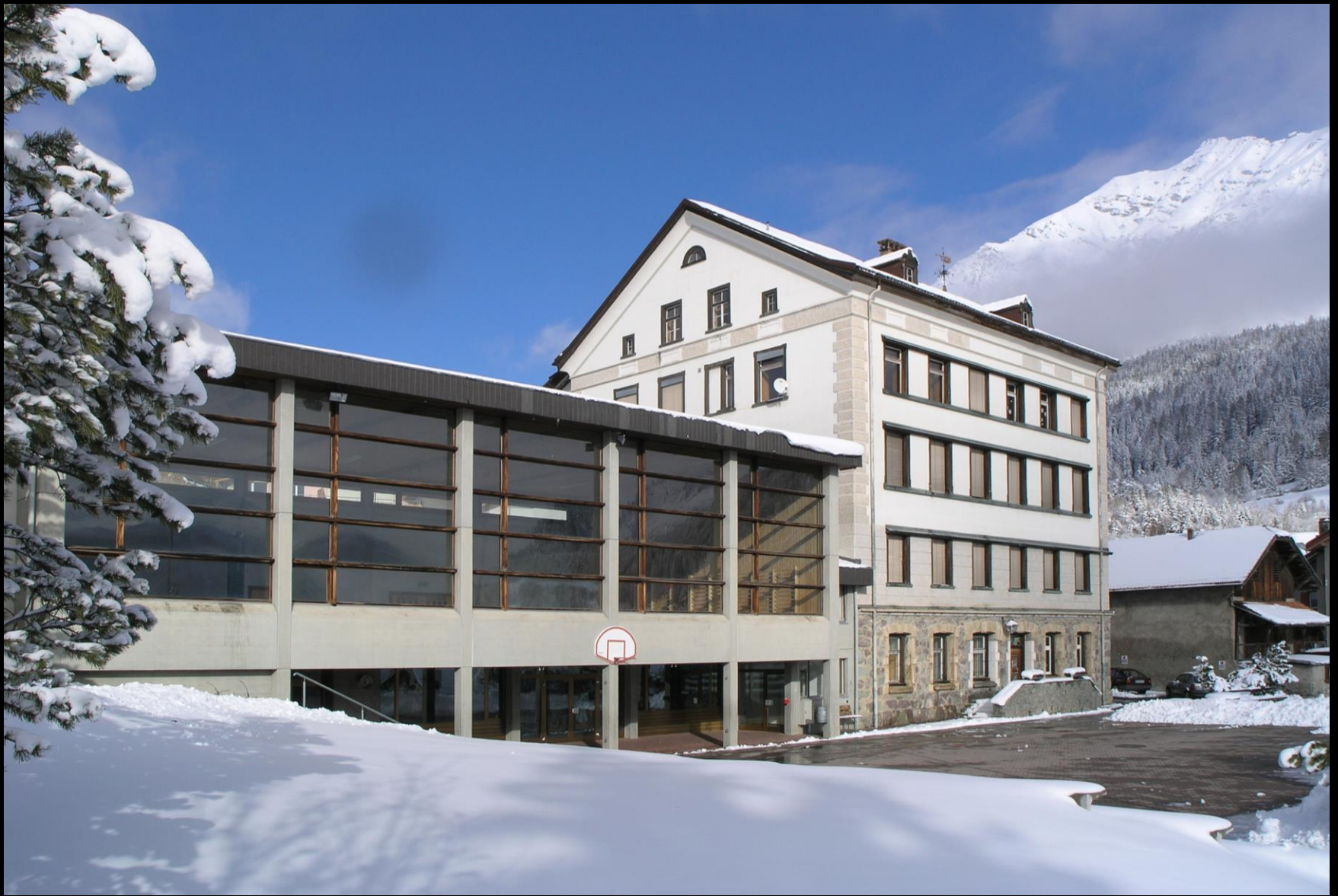
Vorzustand Mehrzweckhalle und Schulhaus
