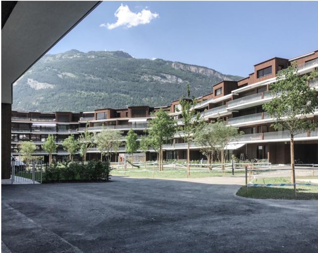
148 Wohnungen anstelle der alten Fabrikgebäude der Gestle AG
