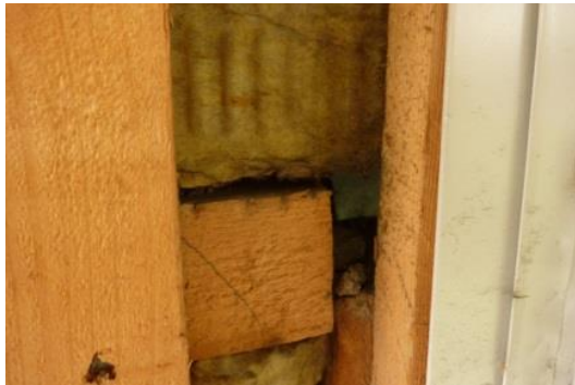
Foto Sondierung Fassade
