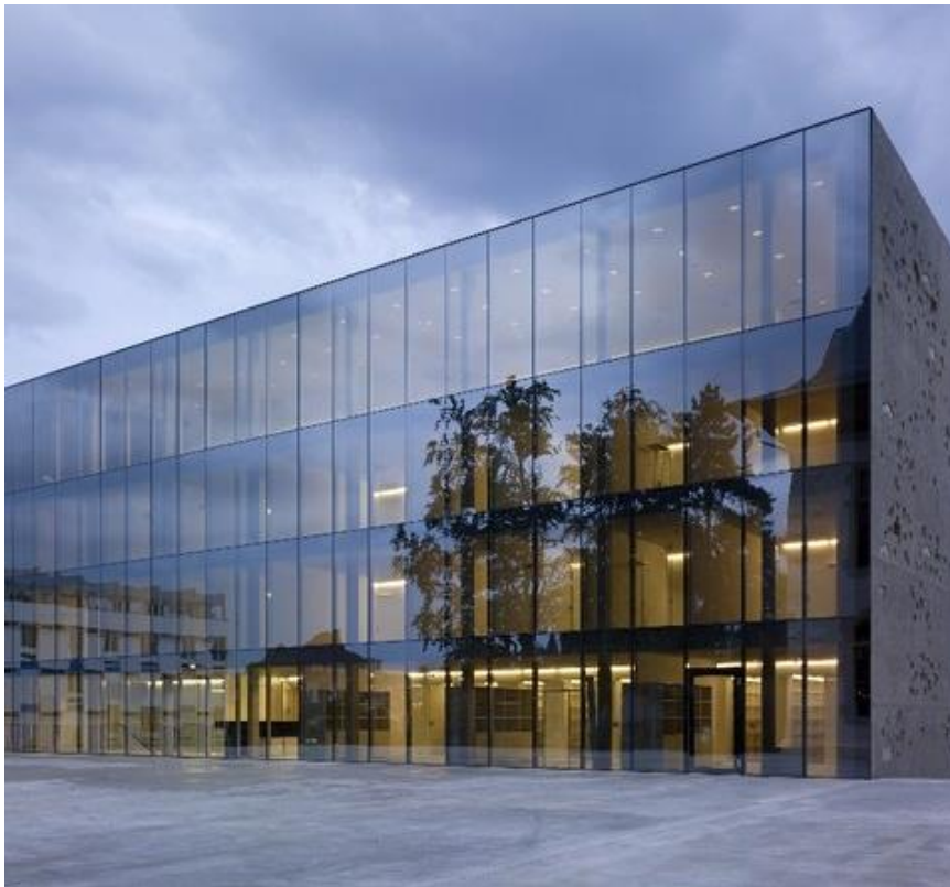
Erscheinungsbild Fassade bei Nacht
