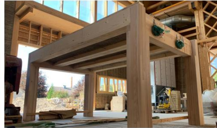
Einbau Thermofühler Brandversuch
