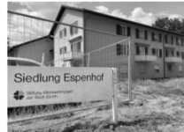
SAW-Siedlung Espenhof 8063, Zürich
